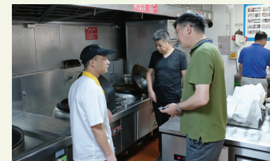
安环专家对员工餐厅燃气设备 进行安全检查
